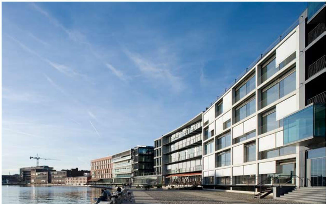
BÜROHAUS HAFENWEG 24, MÜNSTER
